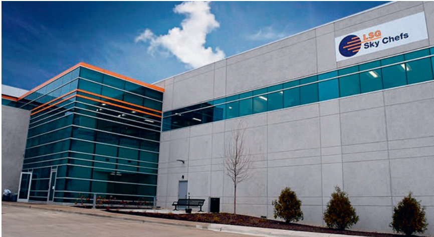
Blick auf den modernen LSG Sky Chefs Betrieb in Chicago, der Ende 2015 eröffnet wurde. Das nach LEED-Standards (Leadership in Energy & Environmental Design) errichtete Airline-Catering-Gebäude ist das weltweit erste, das das Gütesiegel des U.S. Green Building Council (USGBC) erhielt.
